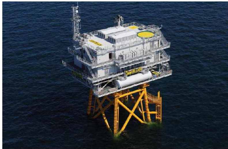
Exemple de poste électrique en mer
