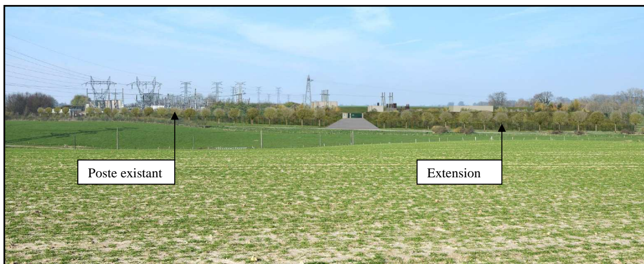
Vue du poste de Sainneville après travaux (Photomontage)
